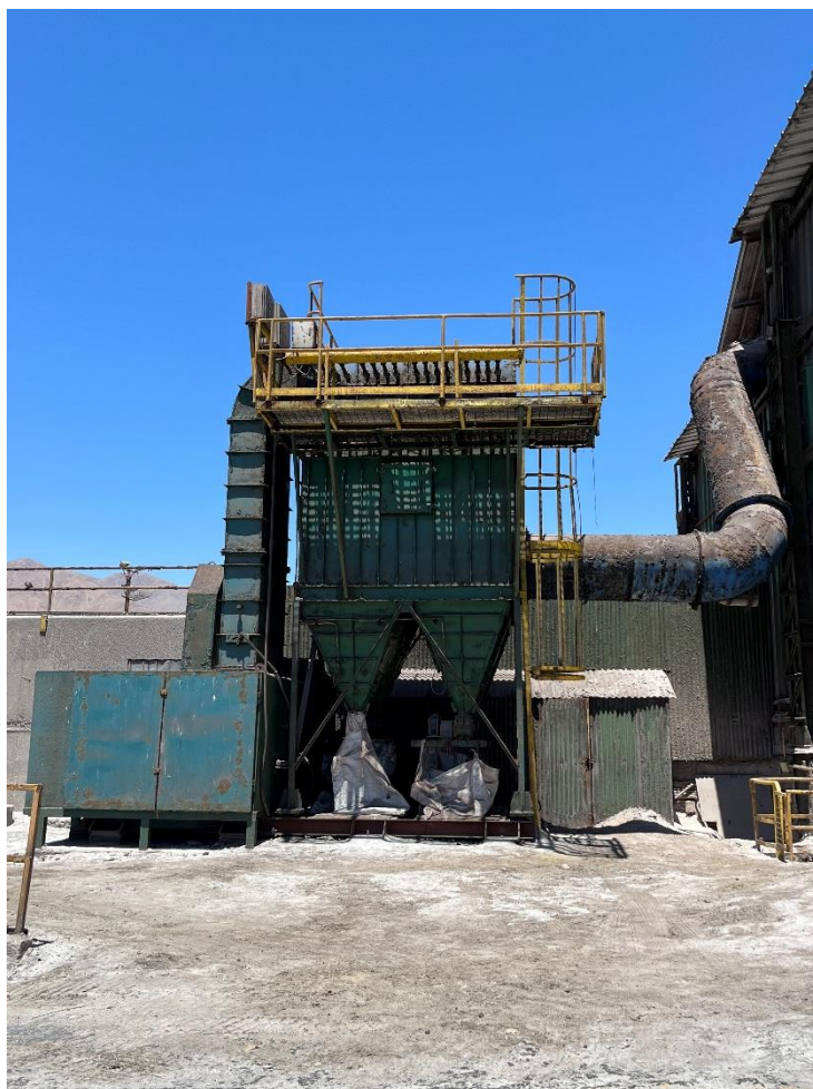
Fotografía N°16: Sistema de captación MP.
