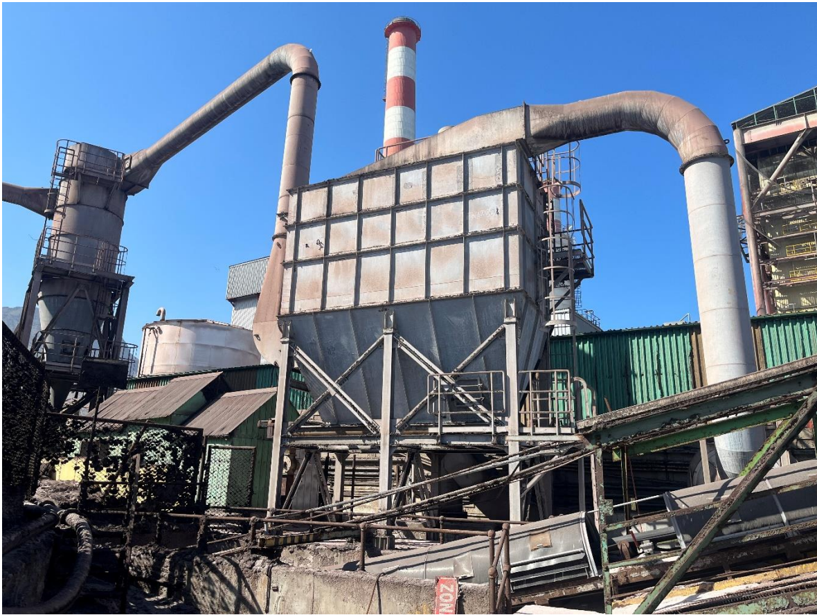
Fotografía N°2: Mejora en sistema de captación del polvo en cuna de volteo.
