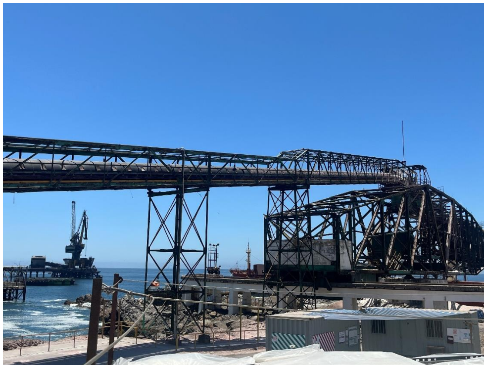
Fotografía N°17: Cobertura de correas transportadoras.
